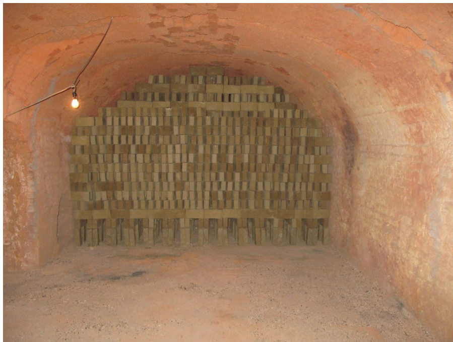
Slika 36: Zgrada ciglane – kružna peć
